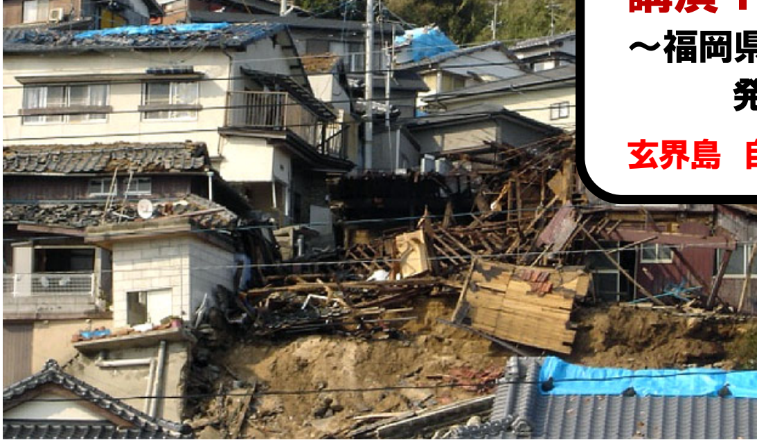
玄海島の被災状況(福岡県県土整備部砂防課提供)
